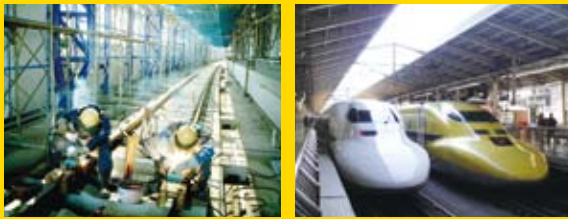
エンクローズ溶接・ガス圧接
