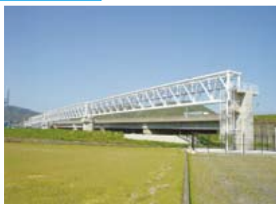
● トラス水管橋
